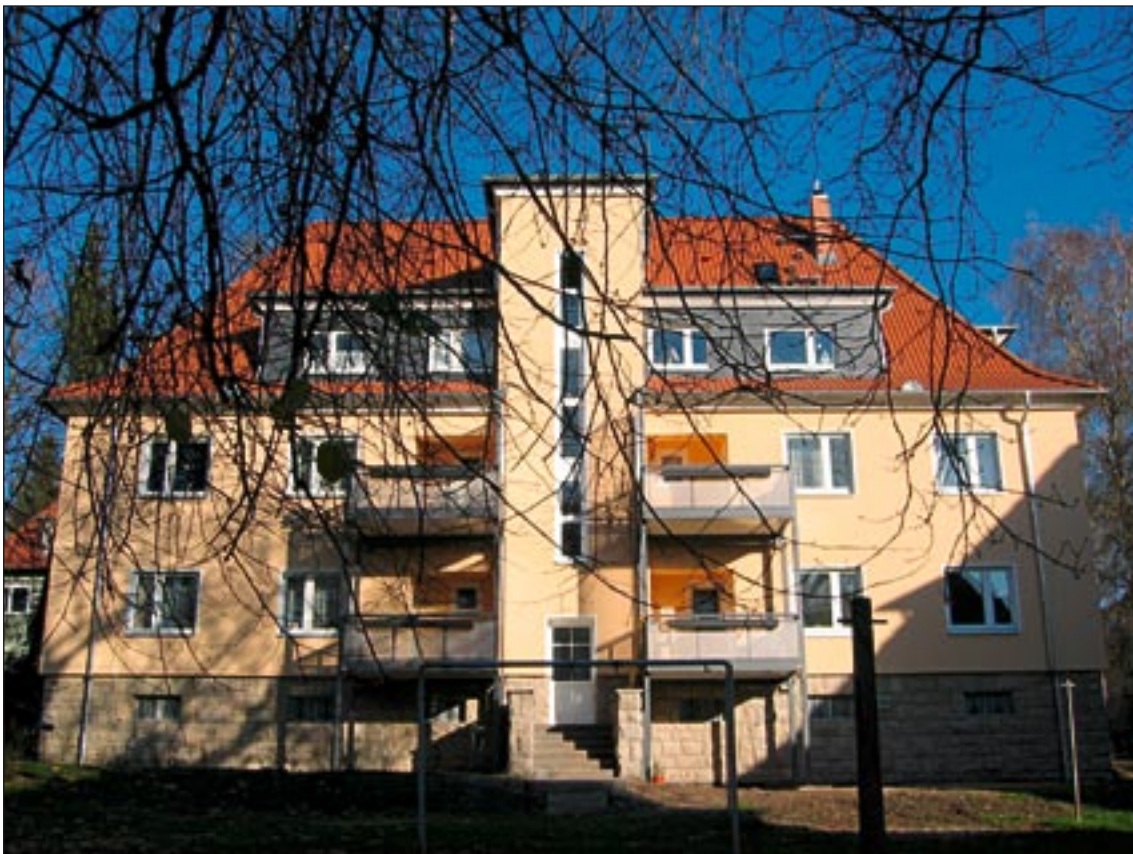
Sanierungsmaßnahme in der Tecklenburgstraße 6
